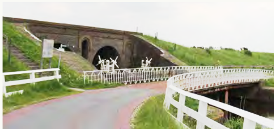
Cultureel erfgoed van sluizen, bruggen en waarhuis
