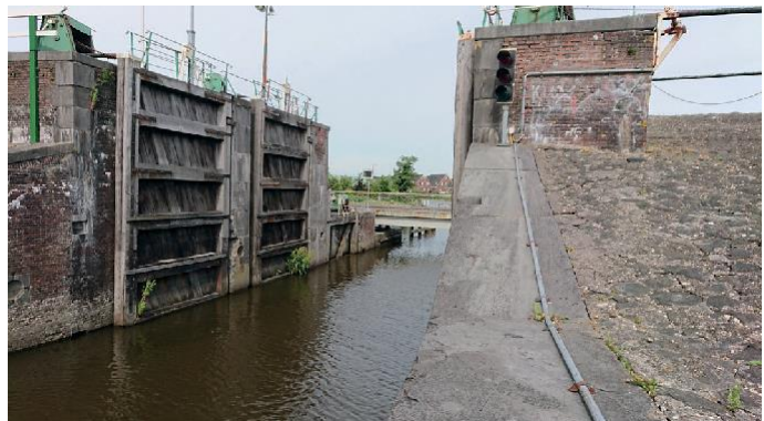
Figuur 11 - De Hunsingosluis nabij Zoutkamp (2019).
