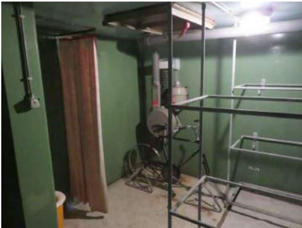
Afbeelding 4.2 De atoomschuilkelder onder gemaal de Drie Delfzijlen, inclusief de authentieke fiets aangedreven luchtverversing
