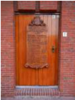
V 33. Kleine toegangsdeur gemaal. (gemaal De Drie Delfzijlen)
