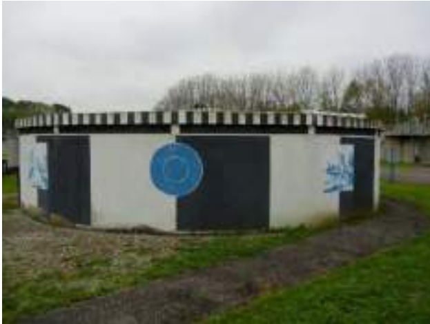
V 69. Silo. (zuivering Weiwerd)
