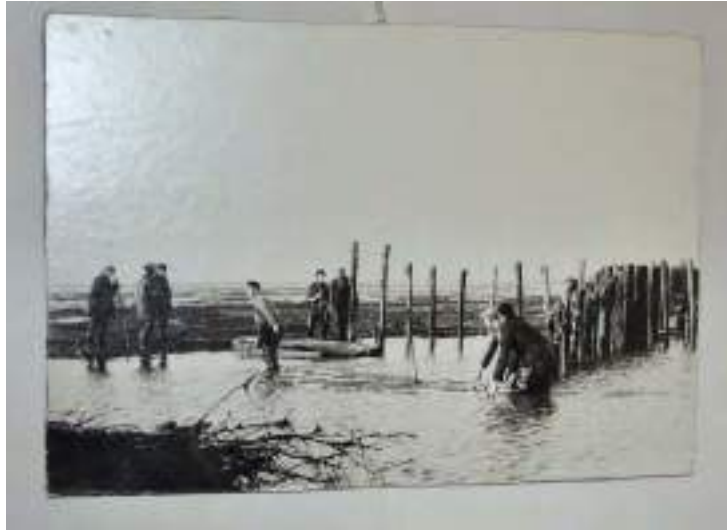
Aanleg van rijdsdammen
