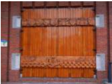
V 34. Grote toegangsdeur gemaal. (gemaal De Drie Delfzijlen)
