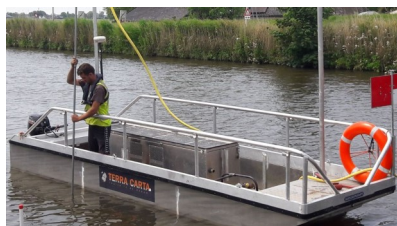
Terra Carta aan het werk vanaf het Water. Kabels en leidingen opsporen.
