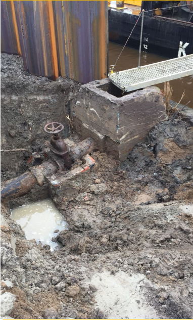
Aangetroffen betonnen put
