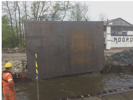
Eén van de oplossingen wordt geplaatst: een verkort schot
