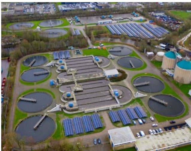
Voorbeeld: zonnepanelen bij RWZI Leeuwarden
