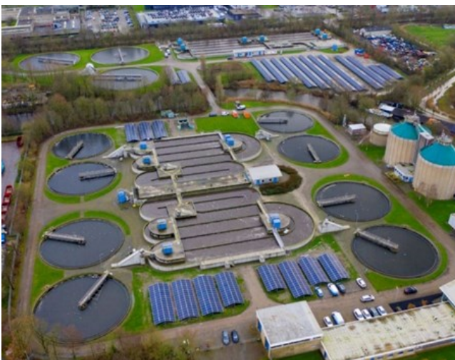
Voorbeeld: zonnepanelen bij RWZI Leeuwarden
