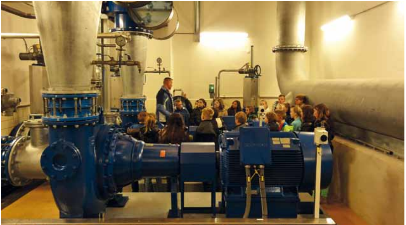
RONDLEIDING BASISLEERLINGEN IN HET RIOOLGEMAAL GRONINGEN
