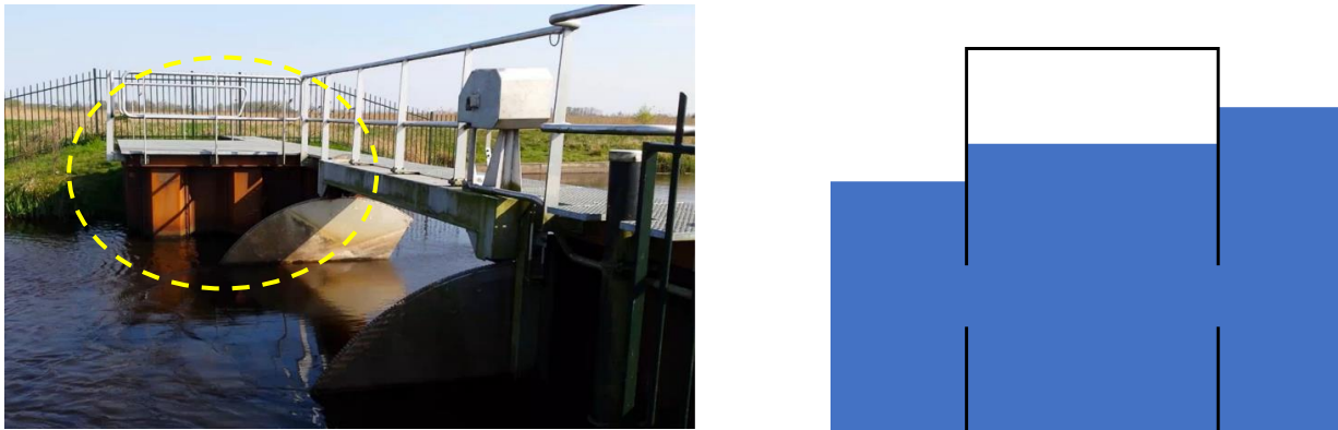
Figuur 2. Een impressie (links) en een schematische doorsnede (rechts) van de vispassage bij de Doolhofstuw (type De Wit-vispassage). De klepstuw was op het moment van de foto gestreken en vormde geen migratiebarrière.
